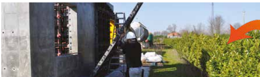
DÉCOFFRAGE DES MURS
