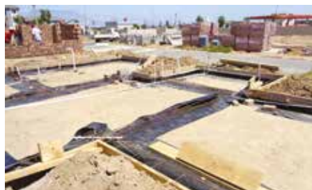
EXCAVATION & INSTALLATION COFFRAGES DES POUTRES DE FONDATION ET RENFORCEMENT
