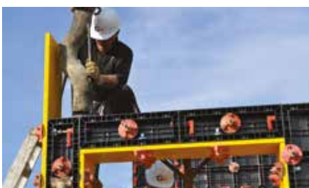
COULAGE DE BÉTON
