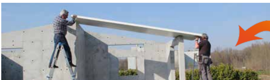
INSTALLATION DE TOIT ET CADRES
