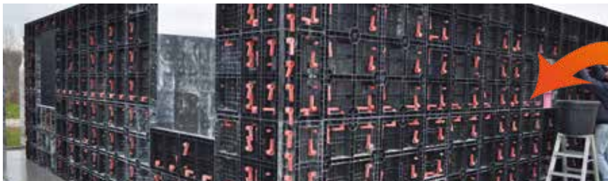
INSTALLATION DES COFFRAGES DES MURS
