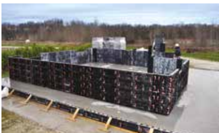
INSTALLATION DES PANNEAUX
