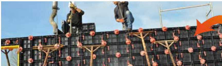
COULAGE DES MURS EN BÉTON
