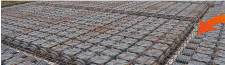
CRÉATION DE LA DALLE DE FONDATION
