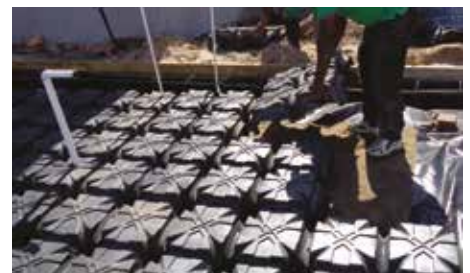
INSTALLATION DU SYSTÈME MODULO ET DE LA MAILLE DE RENFORCEMENT SUPÉRIEURE
