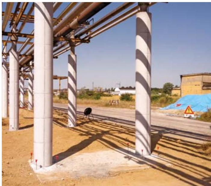
I motivi possibili di intervento su colonne esistenti sono svariati, ma si possono riassumere principalmente nella sostituzione del calcestruzzo e dei ferri deteriorati dall'azione degli agenti atmosferici, la riparazione in caso di incidente, l'incremento della capacità di carico, o il rivestimento di strutture metalliche per aumentarne la resistenza al fuoco.
