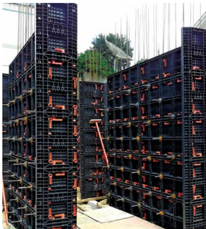
I setti di muro sono costruiti per contrastare gli effetti di carichi laterali come il vento o i terremoti che agiscono sulle strutture. Grazie a Geopanel è possibile realizzare setti di muro in modo facile e preciso. La vasta gamma di dimensioni e la loro facilità d'uso aggiungono flessibilità necessaria per le operazioni di cantiere.
